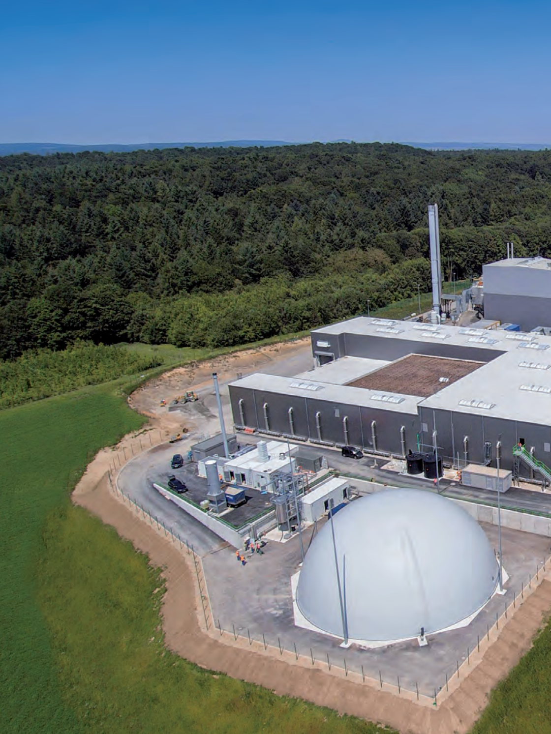
Luftaufnahme der Bioabfallvergärungsanlage mit Biomethaneinspeisung
