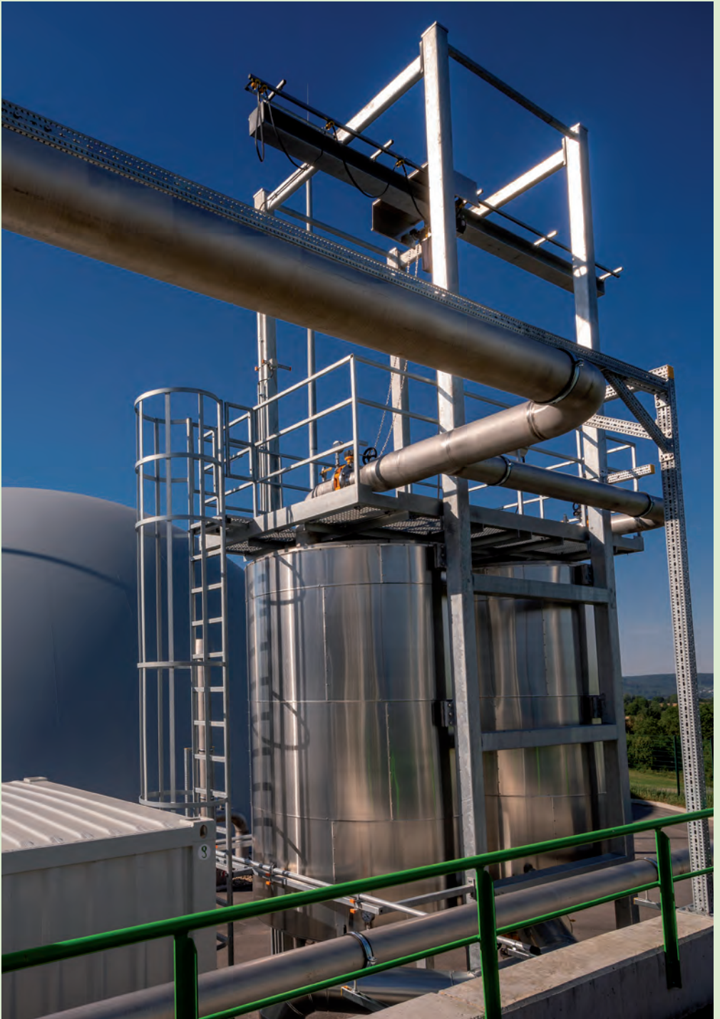
Feinentschwefelung mittels Aktivkohlefilter
